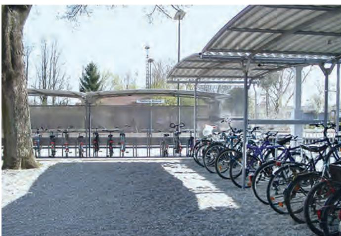
Abris unilatéral, disposition d'angle. Toiture en profilés de tôle d'acier.
